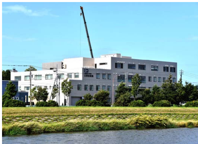
伏古川からみる五稜会病院。秋空に突き抜けるようにクレーンが伸びています。多目的ホールを含めた第二期工事が急ピッチで進められています。年内には完成です。
